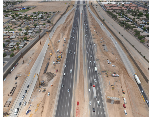
Vías de acceso de la Carretera I-10 Pápago entre las avenidas 51 y 67
