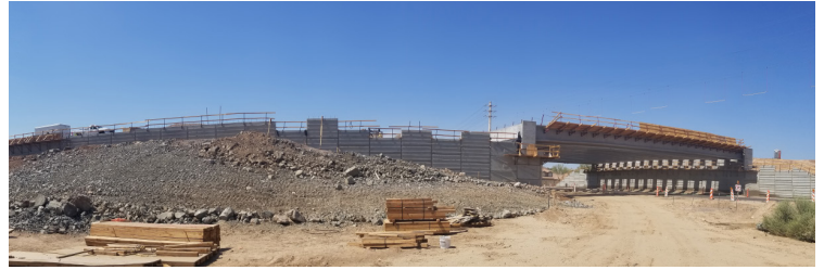
Construcción del puente sobre la Calle 24
