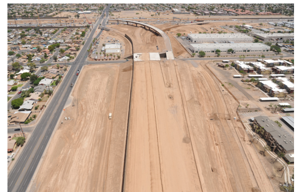
Vista aérea de la Avenida 59 al sur de la Calle Roosevelt antes de la construcción de la vía lateral
