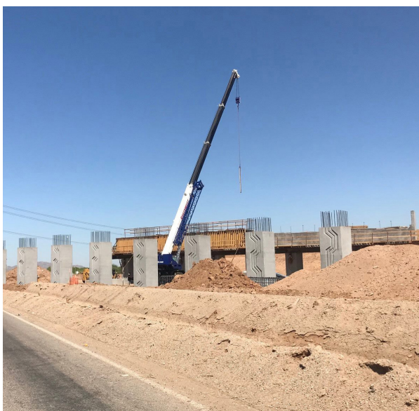
Formación de tapas para el puente del intercambio de Estrella Drive
