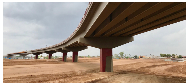
Puente a desnivel del Periférico 202 con dirección al norte
