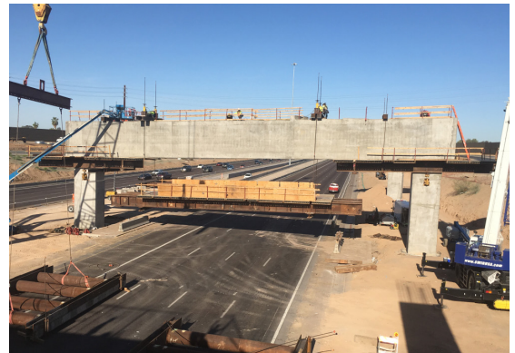
Baja del falso puente del puente al oeste de la Avenida 59
