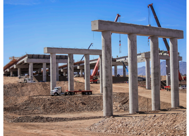
Construcción de los dos puentes de media milla del Río Salado (foto cortesía de ADOT)
