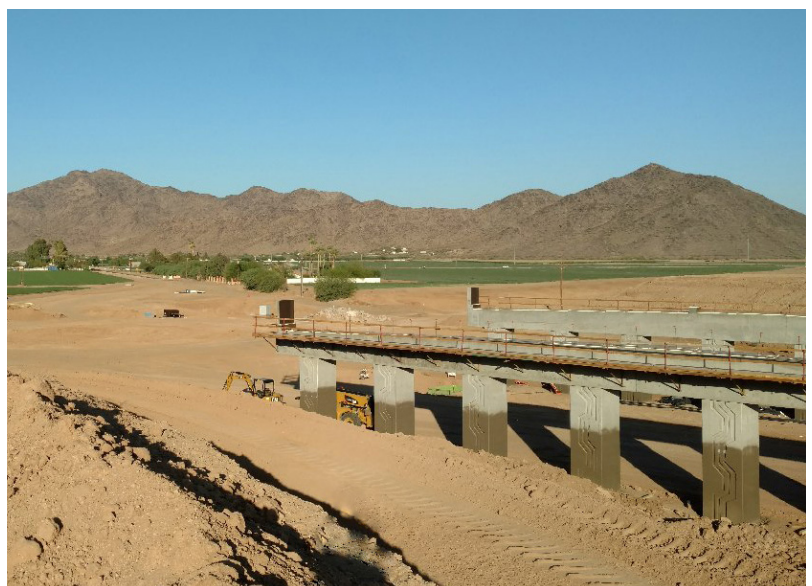
Preparativos para la colocación de las vigas para el intercambio de Estrella Drive
