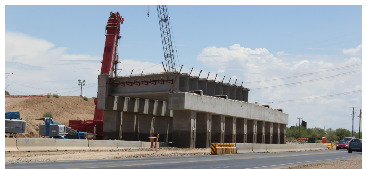
Colocación de vigas del puente de la Avenida 51
