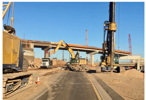
Eliminación de la rampa de ingreso a la I-10 al este de la Avenida 59
