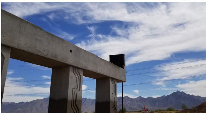
Estructura del puente de Estrella Drive
