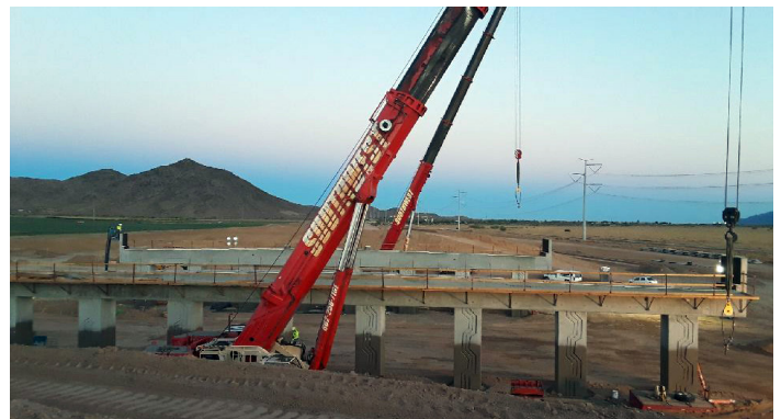
Preparativos para colocar vigas del puente del intercambio de Estrella Drive
