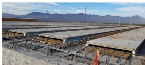
Completando las plataformas del puente de la Avda. 17
