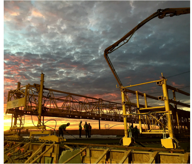
Vertiendo la plataforma del puente de la Calle 40
