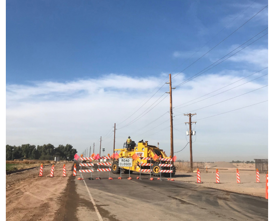
Cierre de la Avenida Southern para acelerar la construcción de la calle
