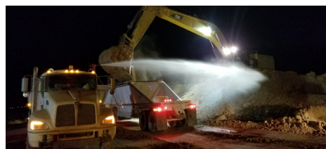
Acarreo de tierra de noche para el terraplén de la carretera
