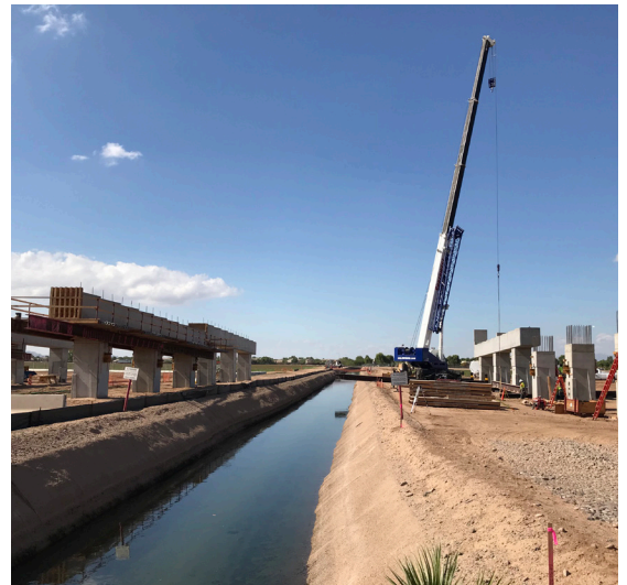
Construcción de pilas para un puente sobre el canal del Distrito de Irrigación Roosevelt
