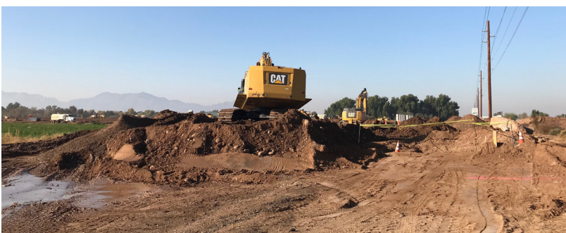
Excavación para instalar drenaje a través de la Avenida Southern
