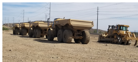
Transporte de roca de la voladura controlada de roca
