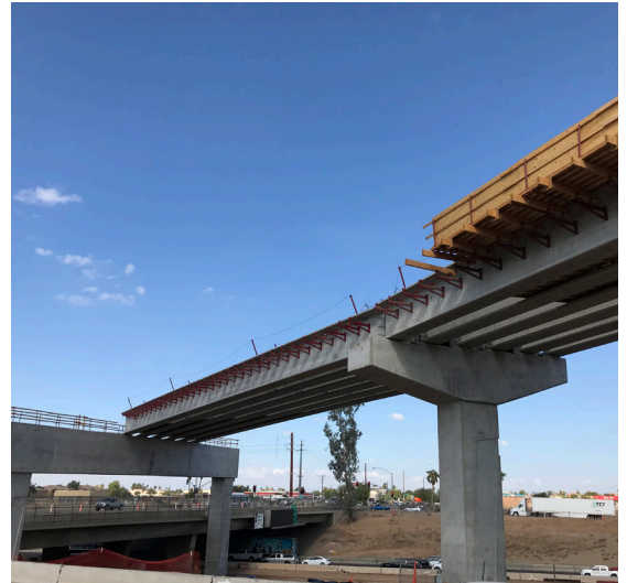
Construcción de una rampa a desnivel del Periférico 202 hacia el norte, a la I-10 hacia el oeste
