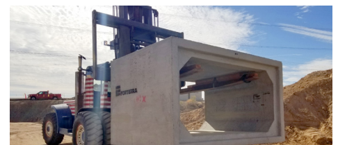
Colocación de alcantarilla premoldeada cerca de la Calle 24
