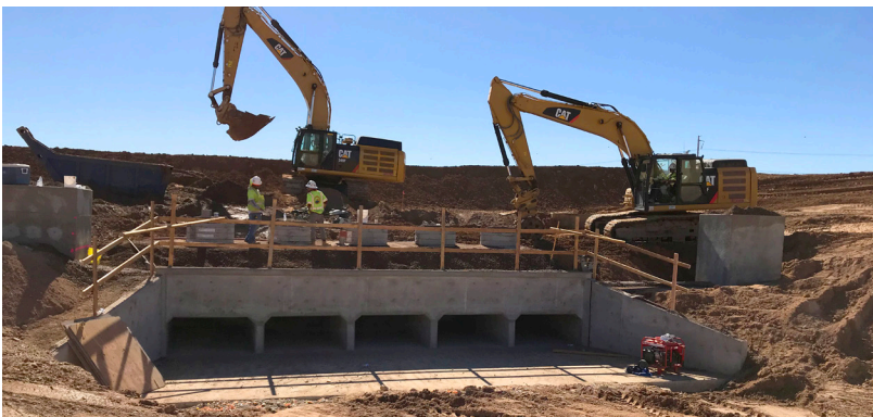
Instalación de la alcantarilla en Elliot Road
