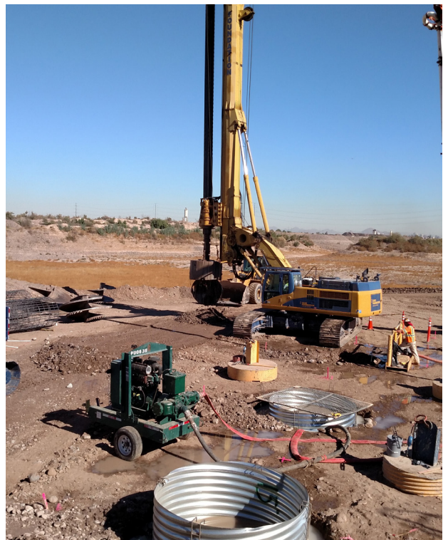
Excavación en el Río Salado para muelles del Puente
