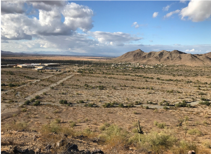
El Segmento Centro incluye aproximadamente tres millas de nueva carretera.
